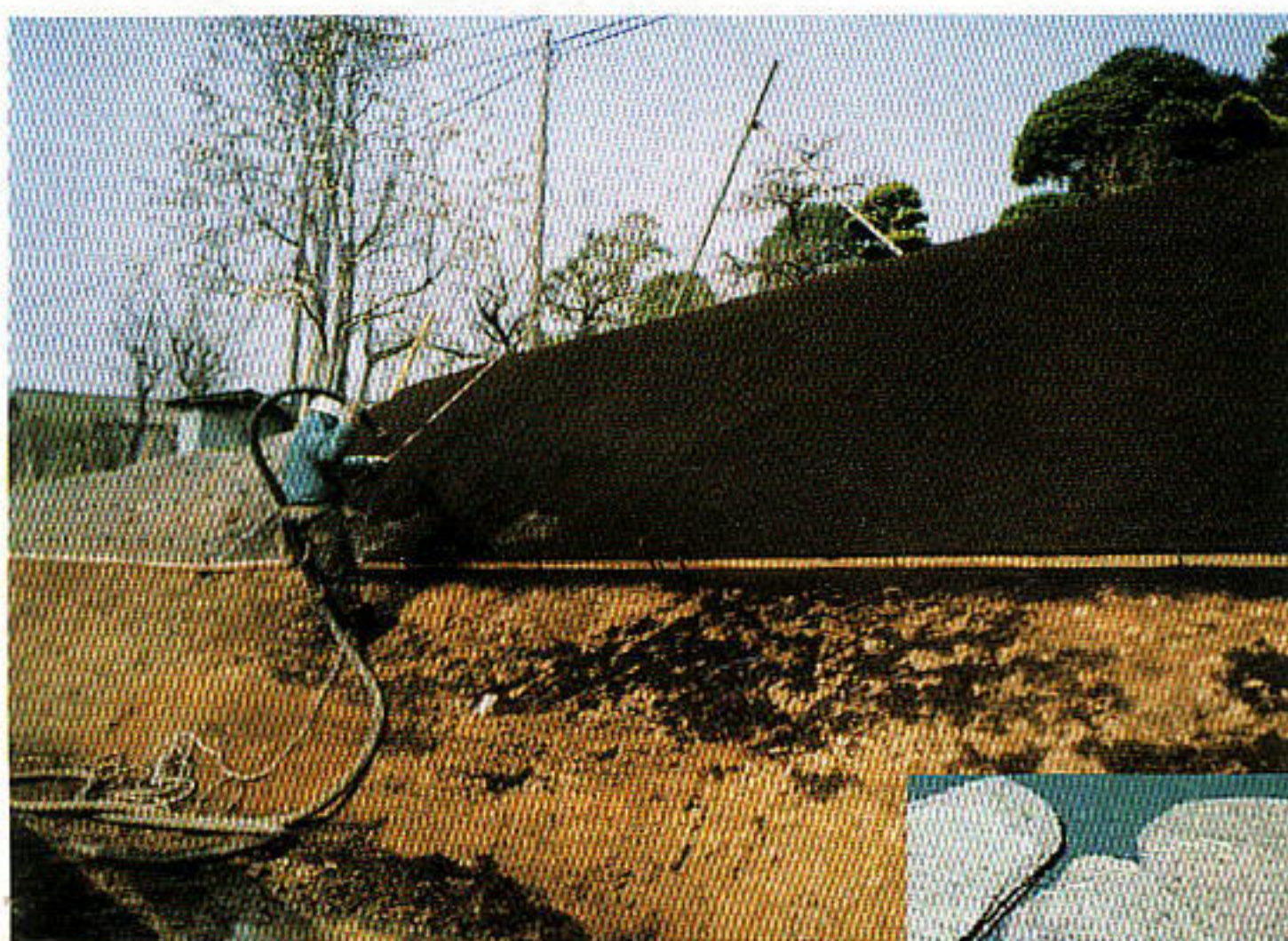
廃ガラスで作った骨材を混入した基盤材を、斜面に吹き付けている様子（上の写真）。右は、廃ガラスを原料にした骨材（右の写真：日本建設技術）
